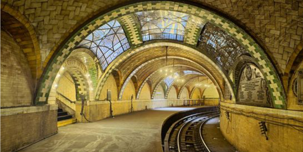
La estación de metro del Ayuntamiento (City Hall) de Nueva York, inaugurada en 1904, con las bóvedas de Rafael Guastavino. / Michael Freeman NUEVA YORK (EE UU)
