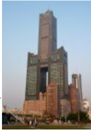
348 metros 1998 Kaohsiung (Kaohsiung) Taiwan, Asia Arq. C.Y. Lee
