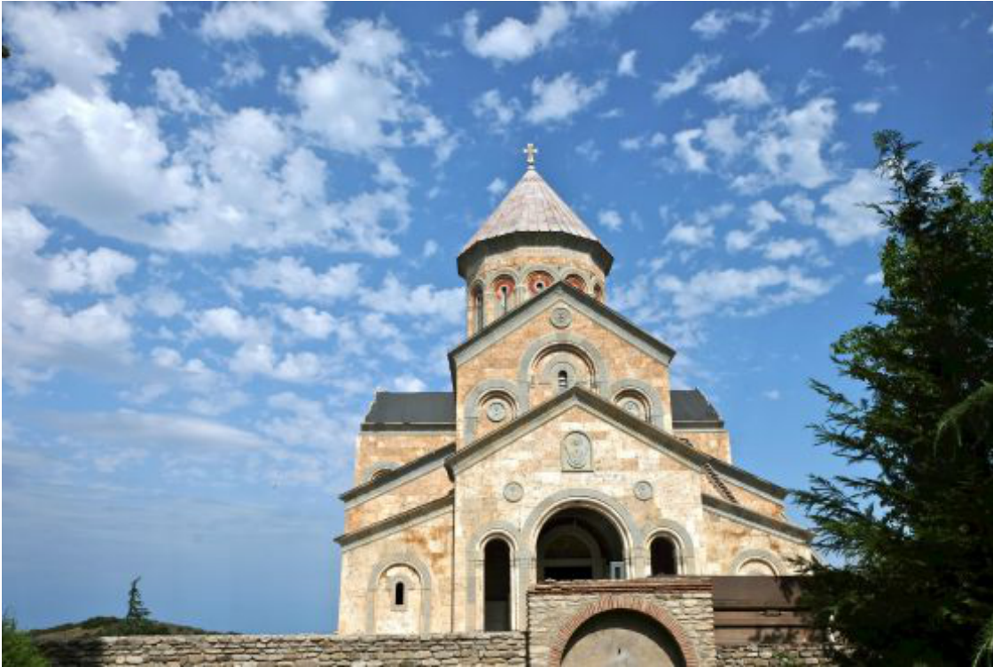
La nueva Basílica de Bobde a punto de ser terminada/ Foto: F. López-Seivane
