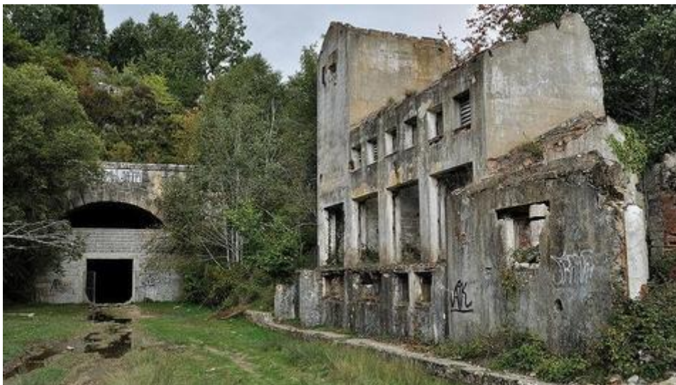
Entrada del túnel de La Engaña, en el extremo sur
