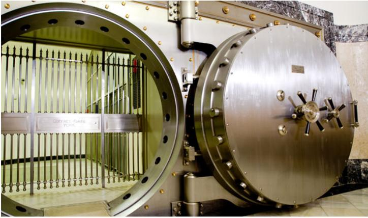
El acceso a la cámara se realiza a través de varias puertas acorazadas. La primera pesa alrededor de 16 toneladas y las demás oscilan entre las 15 y las ocho toneladas. Tienen una tolerancia ínfima. Esto hace que cualquier impureza en el arco impida que encaje correctamente y que puedan activarse los puntos de anclaje. La puerta es de acero, pero no inoxidable, por lo que siempre está recubierta de una fina capa de vaselina para evitar que se oxide.
