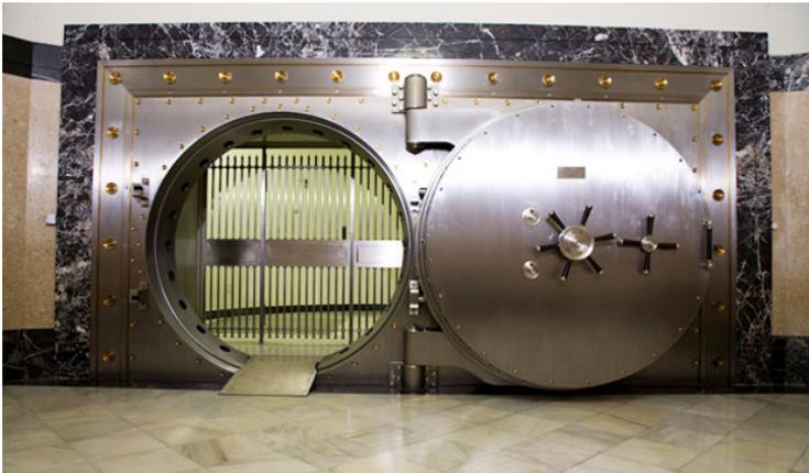
La cámara se encuentra a 35 metros de profundidad y tiene una superficie de 2.500 metros cuadrados. Su diseño parece inspirarse en una construcción similar de la cámara acorazada de la Caja de Ahorros de Viena. Está hecha de hormigón armado y cemento fundido. Las obras de construcción comenzaron en 1932 y duraron dos años y medio. En total, participaron 260 obreros trabajando en tres turnos.
