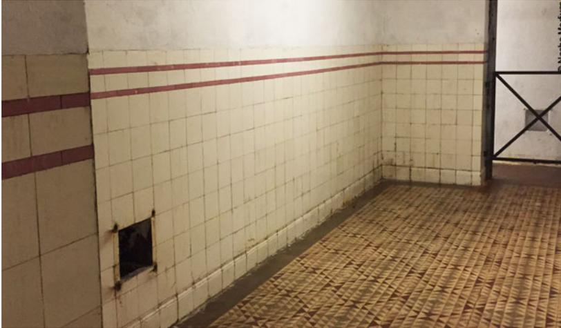
Este búnker hermético con ventilación forzada, preparado para la lucha química, tiene en la parte inferior de sus paredes unas canaletas que sirven para oxigenar el aire.
