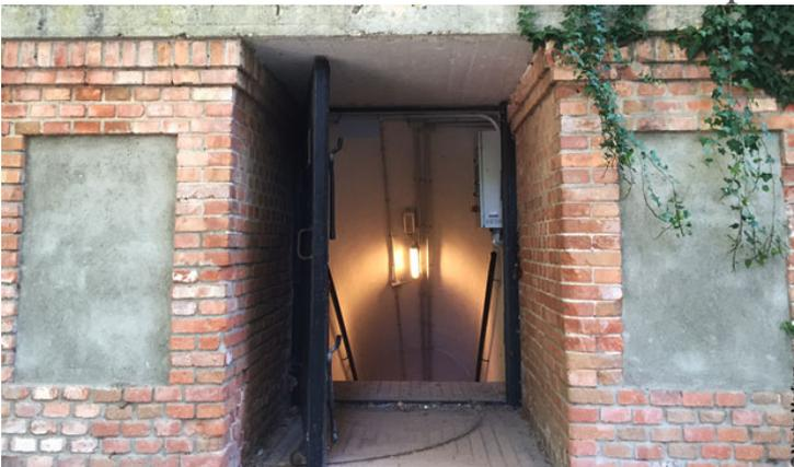
La construcción tiene una estructura girada 90°, pensada para que los obuses que penetraran no llegaran adentro. Se diseña con todo lo que los militares han aprendido durante la Primera Guerra Mundial. Y aunque no llega a usarse en la batalla, sirve como modelo para este tipo de construcciones en la Segunda Guerra Mundial.
